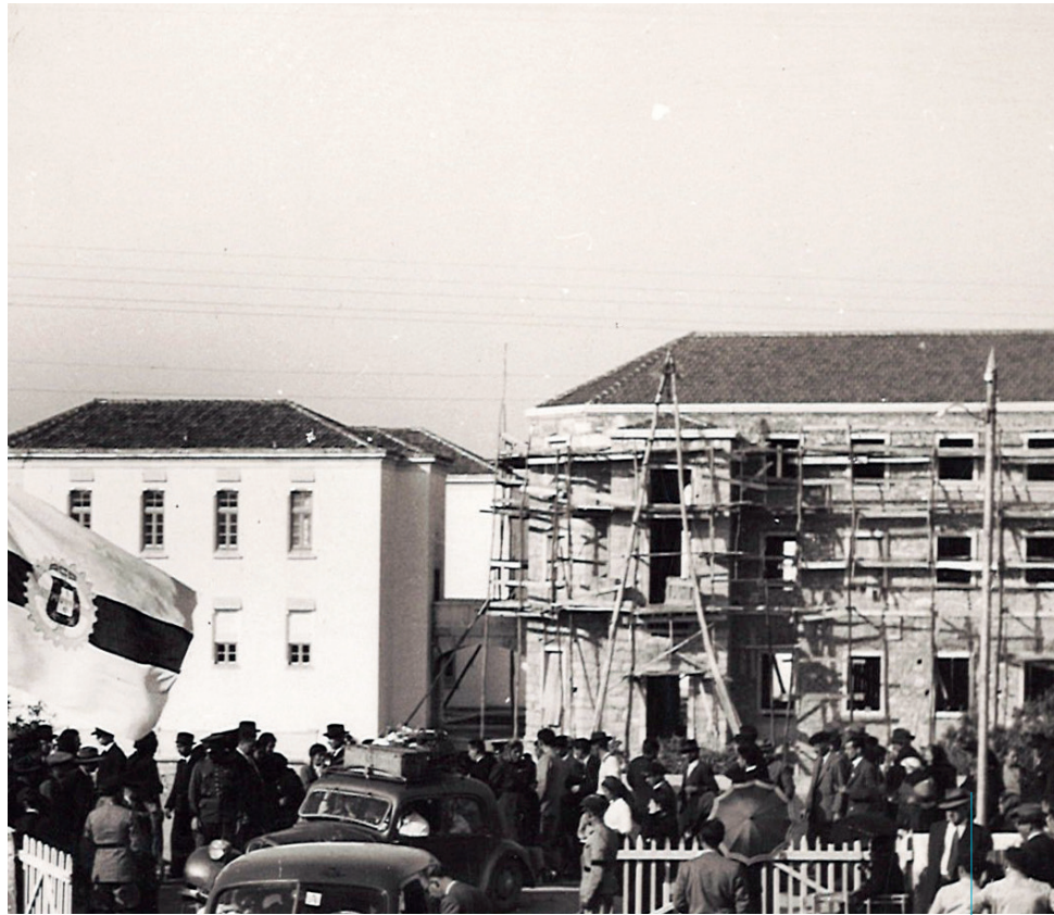
Parque ACP no final da década de 50
